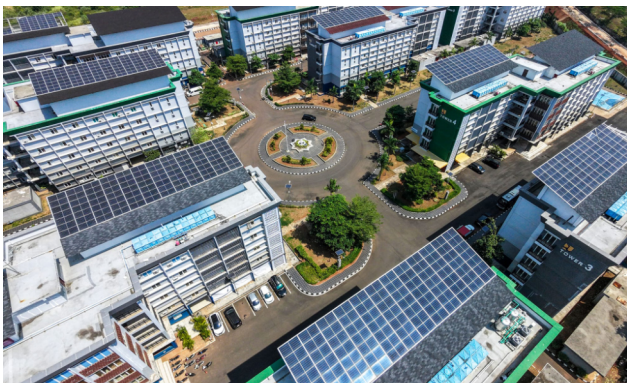
Foto udara penggunaan panel surya di atas rusun yang ditempati pekerja di Kawasan Ekonomi Khusus (KEK) Industropolis Batang, Kabupaten Batang, Jawa Tengah, Selasa (28/7/2026). ANTARA FOTO/Harviyan Perdana Putra
