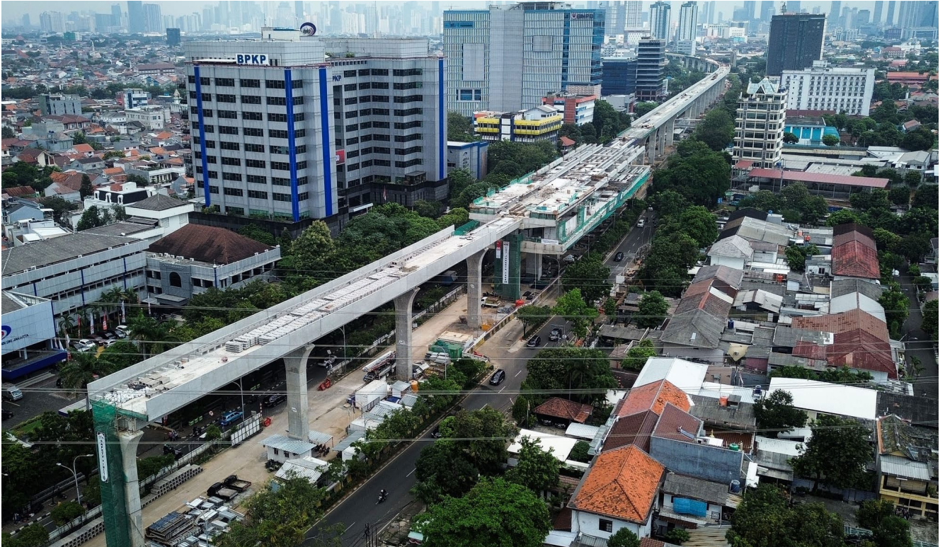
Foto udara proyek pembangunan LRT Jakarta Fase 1B di Jalan Tambak, Jakarta, Jumat (22/8/2025). Proyek infrastruktur masuk dalam PMTB (ANTARA FOTO/Sulthony Hasanuddin)
