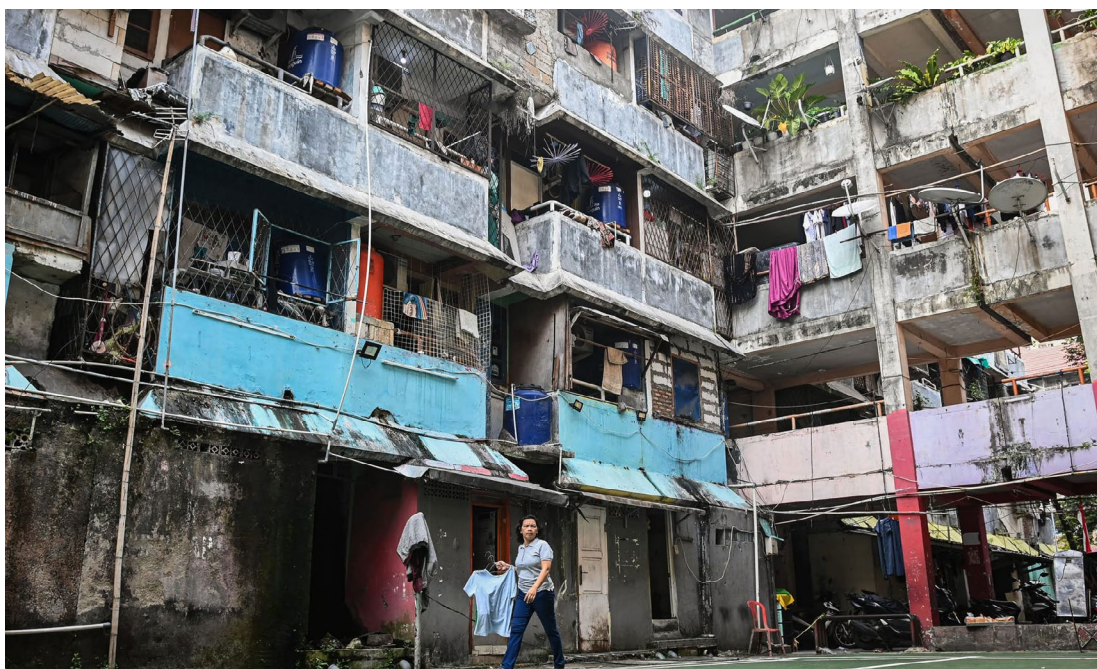
Warga menjemur pakaian di Rumah Susun Bidara Cina, Jakarta, Senin (28/7/2025). Kementerian Perumahan dan Gubernur DKI Jakarta Pramono Anung mengatakan bahwa peningkatan akses hunian layak pada Rencana Pembangunan Jangka Menengah Daerah (RPJMD) tahun 2025-2029 masih mengandalkan penataan kawasan rukun warga (RW) kumuh dan pembangunan hunian vertikal baik berupa sewa maupun milik. ANTARA FOTO/Sulthony Hasanuddin
